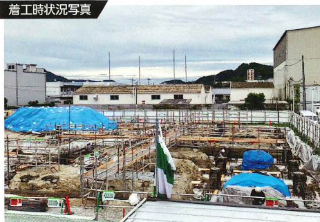
着工時状況写真
