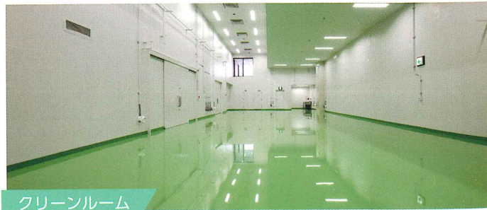
クリーンルーム
