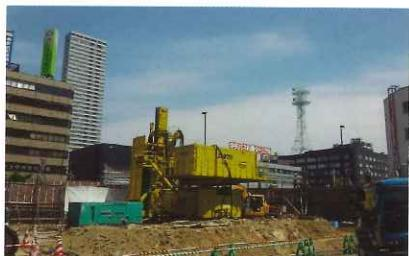
変わるために計画されました。当社は災害時にも適応するよう計画された建物の地下、基礎部分を得意のTRD工法にて施工いたしました。北海道の土質は本州と異なり礫が多く、粘性に欠けるため多くの問題がありましたが、気泡工法に変更してクリアすることができました。また、北海道では例のない工法の
