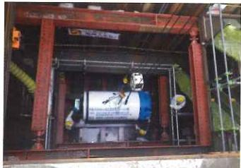
この工事は閉鎖性水域である琵琶湖の水質保全を目的とし、滋賀県内に4つある処理区の内の1つ、東北部処理区下水道管渠(施工延長625m、内径φ1m)をミニシールド工法(泥土圧式工法)により施工したトンネル工事です。作業の発進基地周辺は田園地帯で耕作地にあたり、排水や防音対策には万全を期しました。また地中工事のため、地上からは工事の内容がわからぬので地中のマシンの位置を地上に明示するなどし、地域の方々の関心を高める工夫にも力をいれました。また、工
