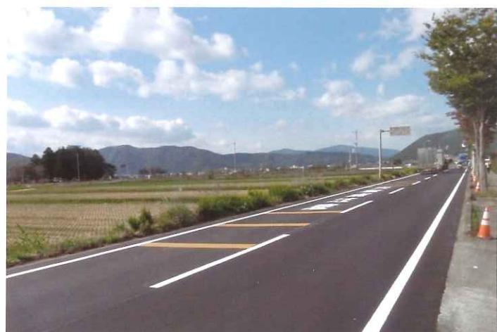
この修繕工事により、車両が快適(平坦性結果0.9mm)に通行できるようになっただけでなく周辺への振動と騒音が軽減され、排水勾配の改善により歩行者への水はねがなくなりました。また、舗装寿命の延長が見込めるため、今後の修繕工事回数を減少させるという点など、工事目的を達成することができたと思います。
